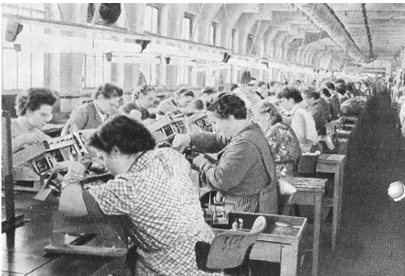
Abb. 6.3 Montage und Verschaltung im Taktverfahren
