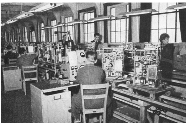
Abb. 6.5 Elektrischer Abgleich im Fließbandverfahren
